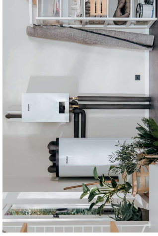
Hydraulikmodul kombineret med en 250-liters cylinder
