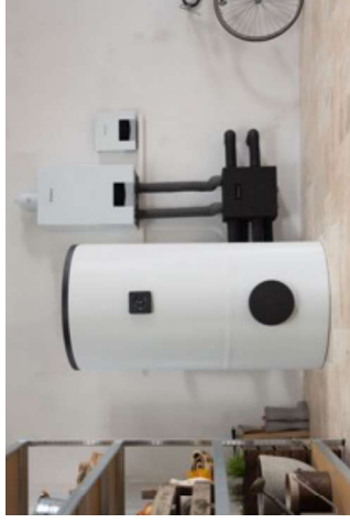
Hybridsystem med gasfyrret ecoTEC-heat, varmepumpe-kontrolenhed og varmtvandsbeholder
