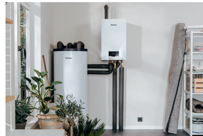
Hydraulikmodul kombineret med en 250-liters cylinder
